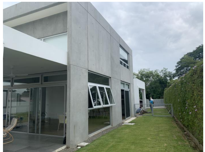
CASA CONCRETO EXPUESTO/RESIDENCIAL LA RAMBLA
