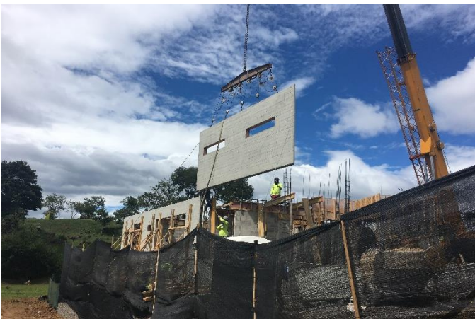
MONTAJE DE PAREDES CON TEXTURA
